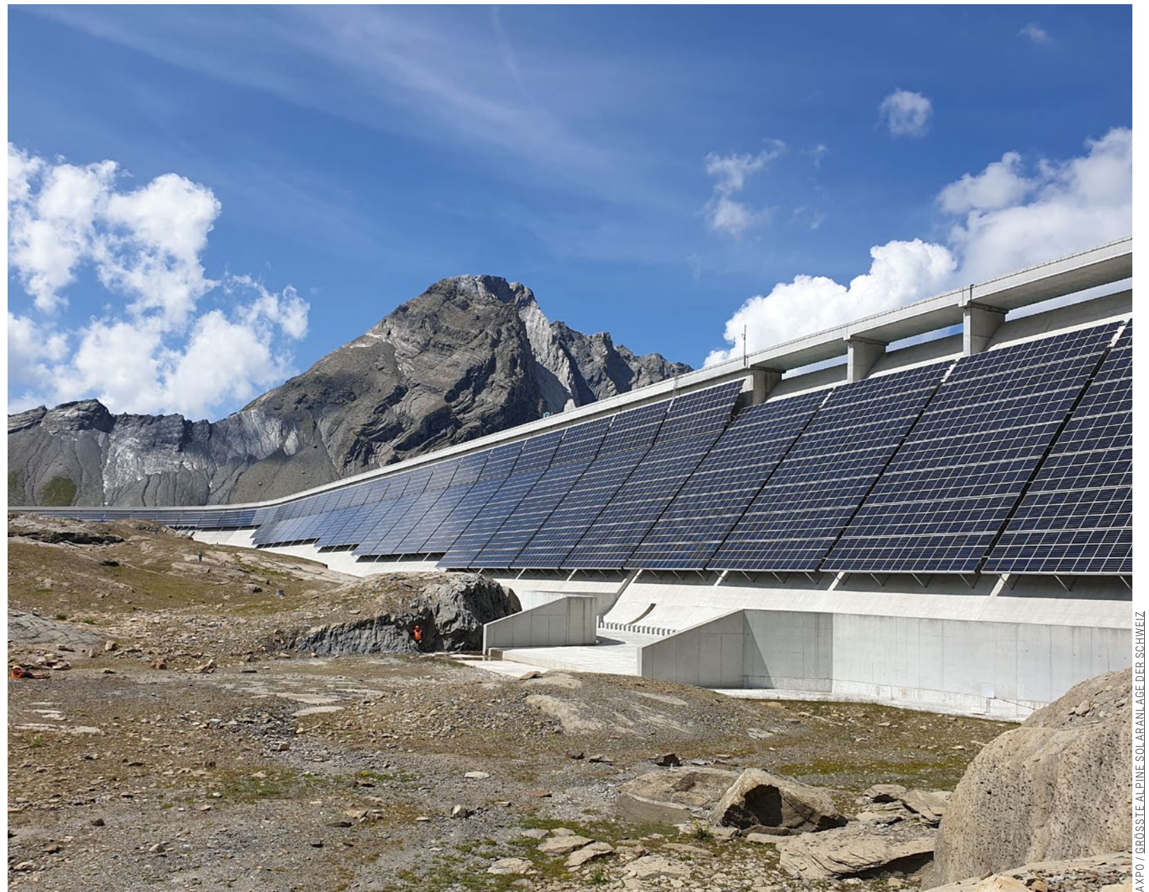
ALPINSOLAR-ANLAGE AN DER MUTTSEE-MAUER | Die Schweiz will mit Anlagen im Hochgebirge die Versorgung mit erneuerbarer Energie im Winter verbessern. Im Kanton Glarus hat das Unternehmen Axpo eine Anlage mit 2,2 Megawatt Peak installiert.
