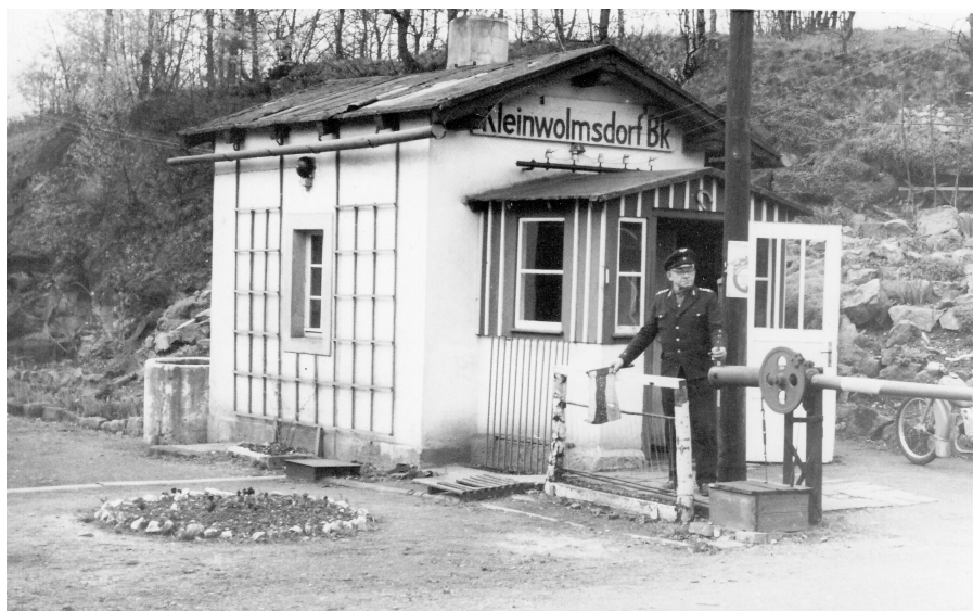
Der Wärter der Blockstelle Kleinwolmsdorf, Strecke Dresden – Görlitz, sichert mit einer Aufwerfschranke den Bahnübergang eines unbedeutenden Weges. Foto: Kaden
