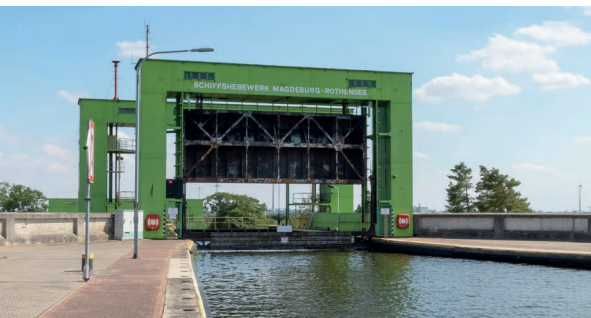
An den Stellen, an denen der Höhenunterschied wirklich groß ist, wartet oft ein Schiffshebewerk.
