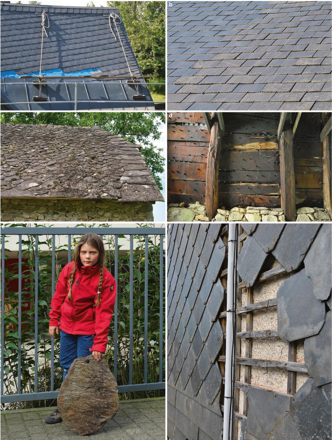
**Abb. 1.3** a Deutsche Deckung (Bogenschnitt), wie üblich in Deutschland mit Nägeln befestigt; b mit Klammern befestigte Decksteine in Brive-la-Gaillarde (Frankreich); c–e große Decksteine (e) werden auf dem Dach (c) mit Dübeln aus Kastanienholz (d) befestigt (Zentralmassiv, Hautefage, Frankreich); f mit Klammern befestigte Decksteine in Martelange (Belgien)
