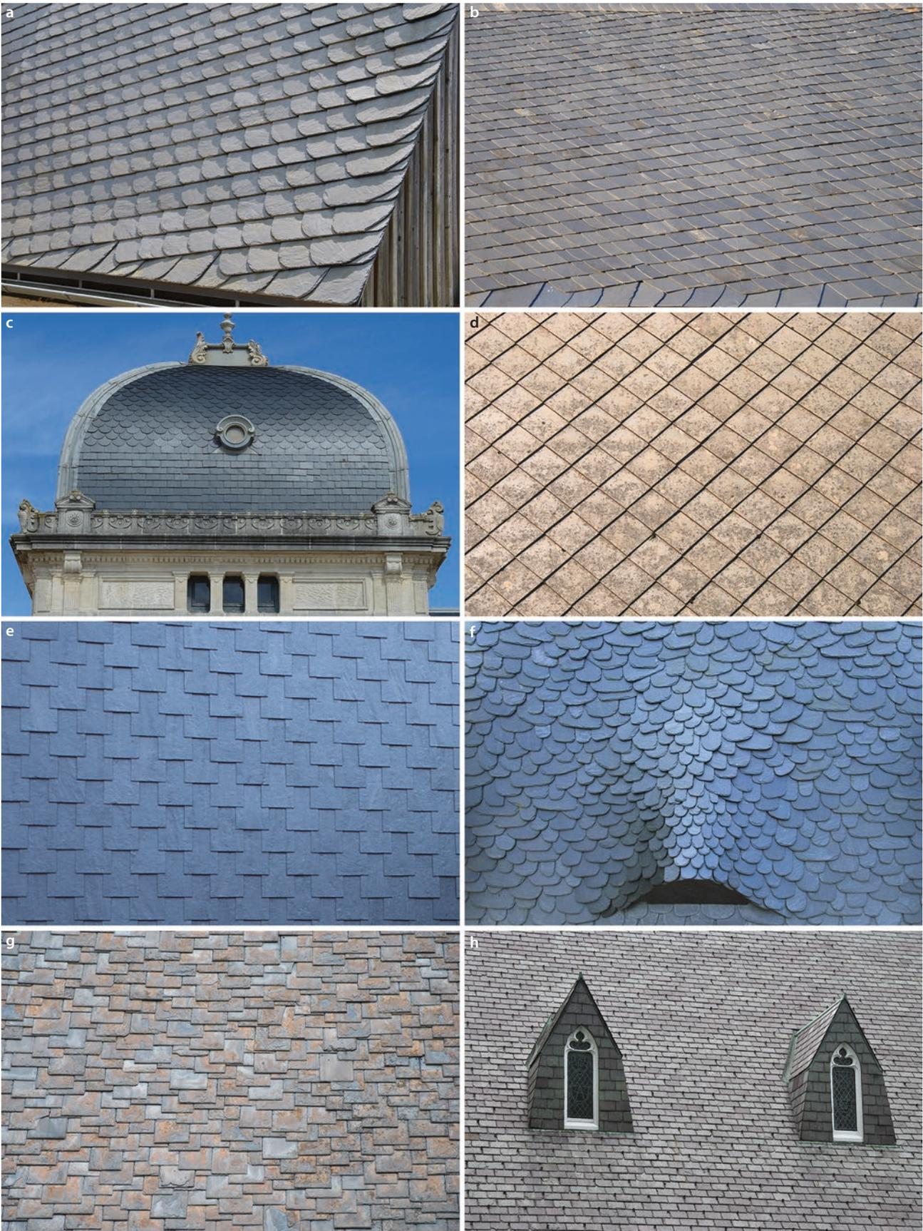
**Abb. 1.1** **a** Deutsche Deckung / Bogenschnitt (Erzgebirge); **b** Altdeutsche Deckung (Erzgebirge); **c** Rechteckdeckung mit Ronde und Carrée (La Rochelle, Frankreich); **d** Spitzwinkel (Ligurien, Italien); **e** gezogene Rechteckdeckung; **f** Wilde Deckung; **g** „staggered butt“ mit Höhen und Breiten (Berlinsville, PA, USA); **h** „standard American“ (Katholische Kirche „Christ the King Parish“ in Rutland, VT, USA)
