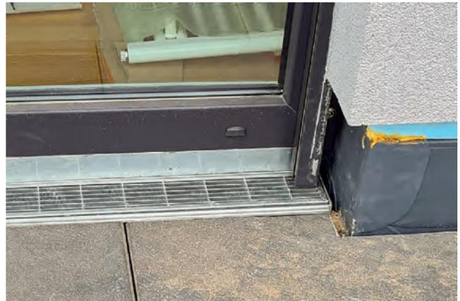
Die Anschlusshöhe der Abdichtung ans Fenster muss oberhalb der Entwässerungsrinne Minimum 50 Millimeter betragen.
