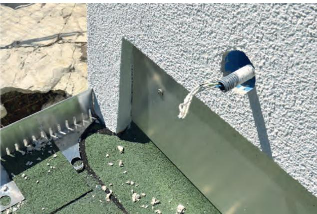
Flachdachabdichtung auf Balkon. Wo ist der Wandschluss am Abschluss der Balkonplatte?
