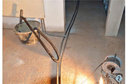
3 Zu dicht verlegte Fußbodenheizungs-leitung, volle Estricheinbettung nicht gegeben
