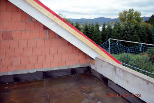
Bituminöse Dampfsperrbahn – bis zur Fertigstellung der Dachabdichtung als Notabdichtung genutzt
