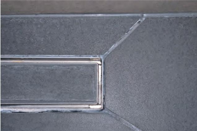
**Anfliesen an die Entwässerungsrinne einer bodenebenen Dusche:** Die Dichtheit sollte über die plastische Fugenmasse erreicht werden.
