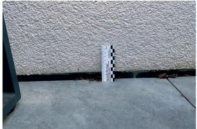
Anschluss der Abdichtung an aufgehenden Bauteilen. Geforderte Mindestanschlusshöhe: 15 Zentimeter ab Oberkante Belag
