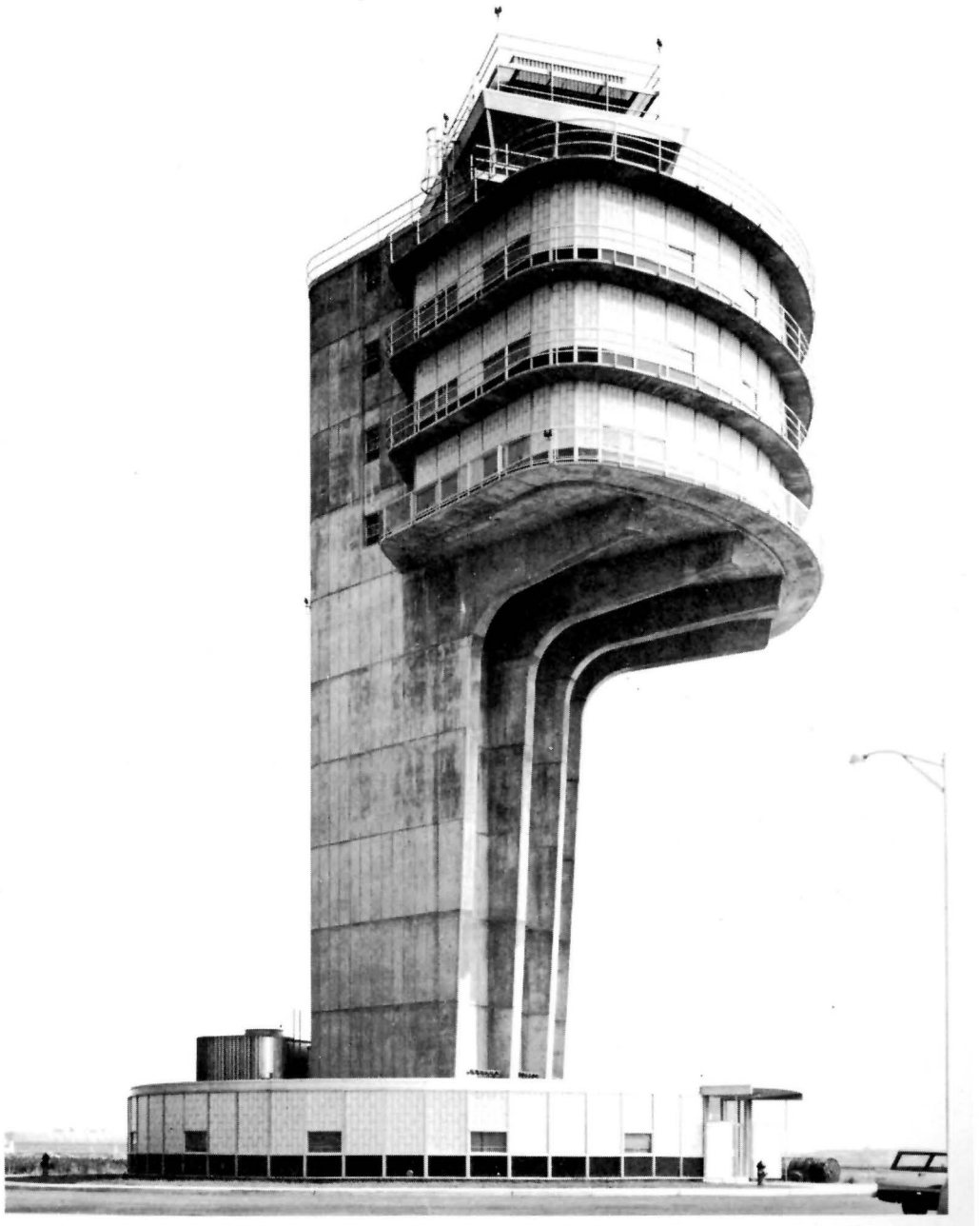
Torre del Aeropuerto de Newark
