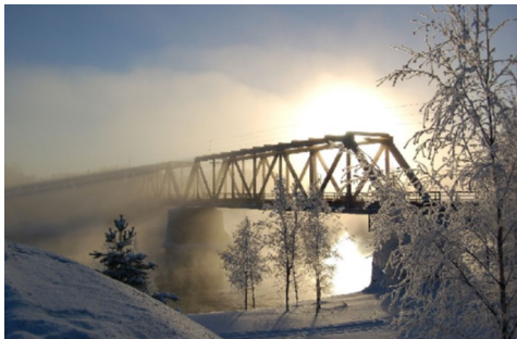
Bild 1.5: Eisenbahnbrücke aus Stahl als Beispiel für das komplexe reale System eines Fachwerks.
