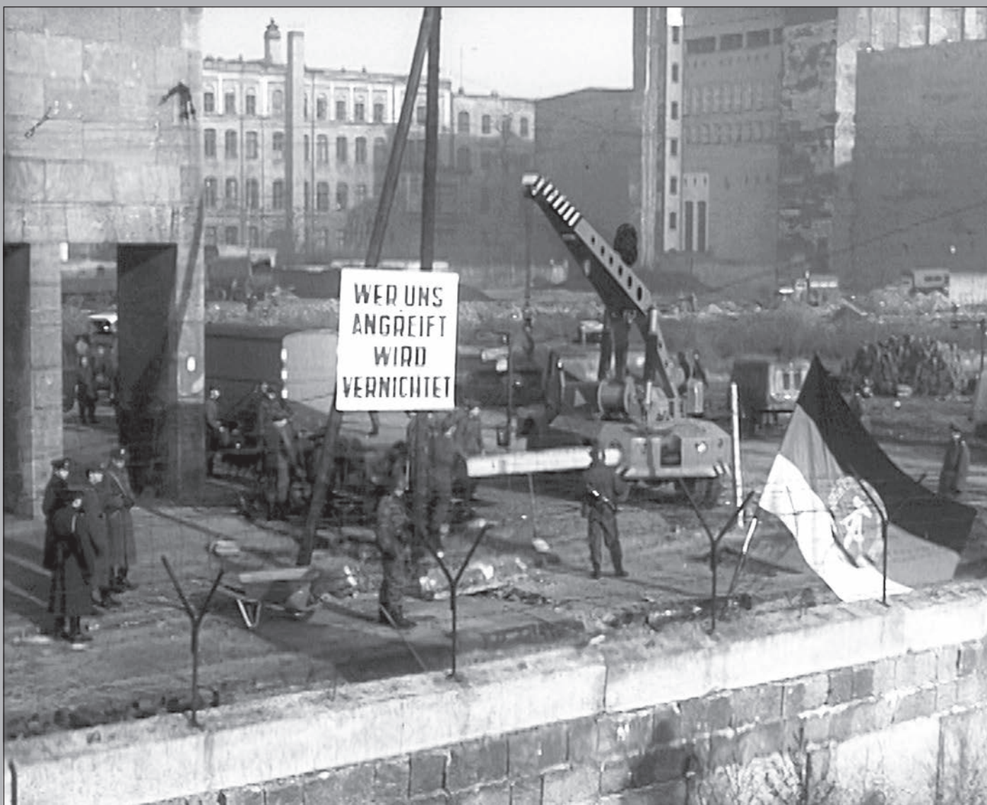
Bauarbeiten im Todesstreifen (Niederkirchnerstraße) mit DDR-Flagge und Agitationstafel „WER UNS ANGREIFT WIRD VERNICHTET“.
