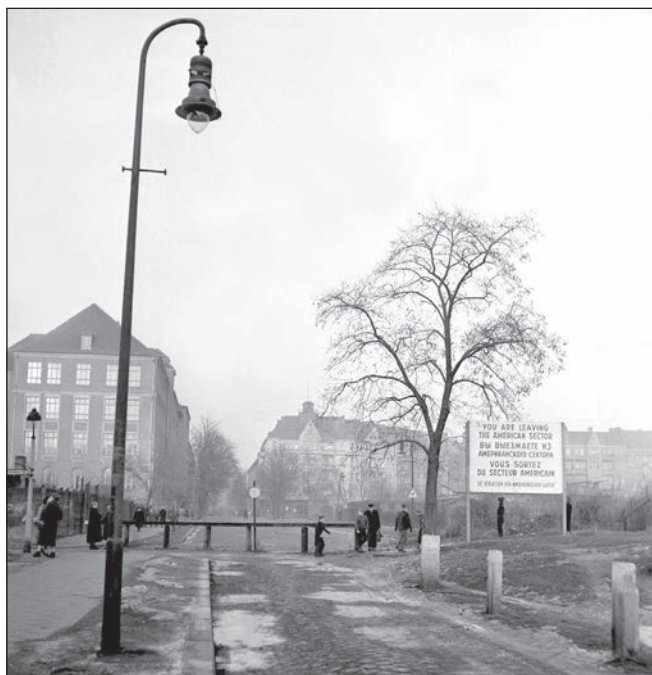
Durch Querbalken und Baumsperre verbarrikadierte Osdorfer Str. (oben) und Heidelberger Str./Wildenbruchstr. (unten). Fotos: Ha-Jo. Helwig-Wilson, 1960.
