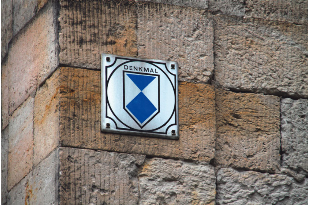
Bild 2-4 Kennzeichen für denkmalgeschützte Gebäude
