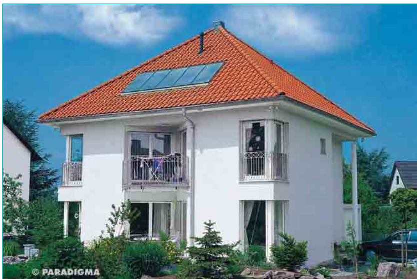
Abb.73 – Die Indach-Solaranlage gibt ein gutes optisches Bild ab. Quelle (7)
