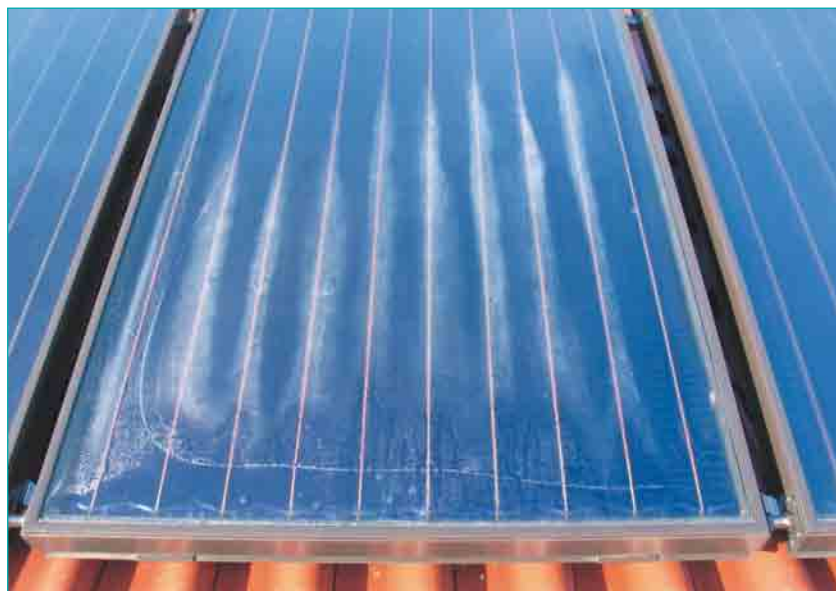
Abb. 104 – Schadhafter Kollektor, zu sehen ist die von innen beschlagene Glasscheibe.
