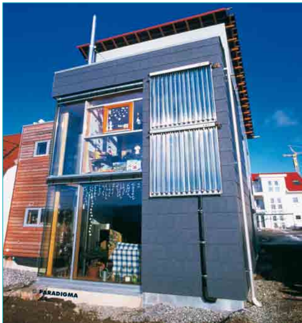
Abb. 75 – Fassadenkollektoren mit Vakuumröhren, auch als Gestaltungselement. Quelle (7)
