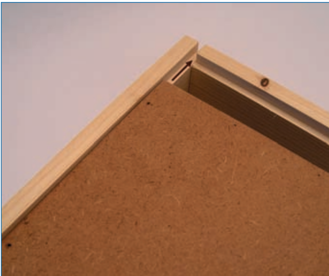
Abb. 1.1.3: Die Schrankrückwand liegt passgenau in den Falzen der Seitenwände und kann angeschraubt werden.
