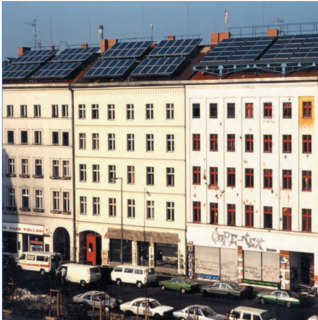
Abb. 1.5 – Fotovoltaik-Dachanlagen können – wie hier in Berlin-Kreuzberg – auch auf den Dächern von größeren Häuserblöcken errichtet werden (Foto Siemens)
