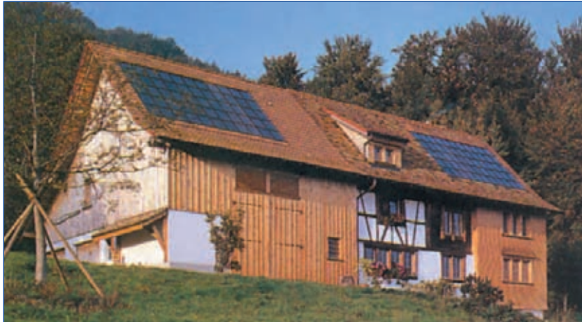
Abb. 5.3 – Bei landwirtschaftlichen Objekten werden Solarzellen für Stromerzeugung an Standorten verwendet, die über keinen Netzanschluss verfügen (Foto FÜW)
