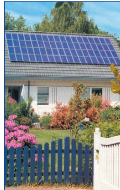
Abb. 1.4 – Was man hat, das hat man, könnte hier der stolze Besitzer dieser Fotovoltaik-Dachanlage sagen, die aus 72 Solarzellenmodulen besteht (Foto AEG)
