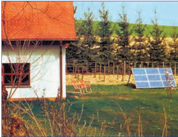
Abb. 5.7 – Kleinere Solarzellen-Flächen können vor der endgültigen Montage aufs Dach auch nur auf ein provisorisches Holz- oder Metallgestell freistehend montiert werden, um den Einfluss von der Ausrichtung (gegen die Sonne bzw. gegen den Süden) und von dem Neigungswinkel auf den Energiegewinn zu testen
