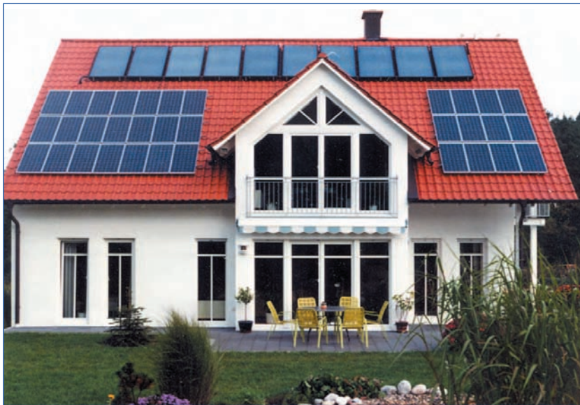
Abb. 1.3 – Beispiel einer kombinierten Solaranlage: auf dem oberen Teil des Daches befindet sich eine Reihe von zehn solarthermischen Kollektoren, links und rechts unten am Dach sind Fotovoltaik-Module angebracht
