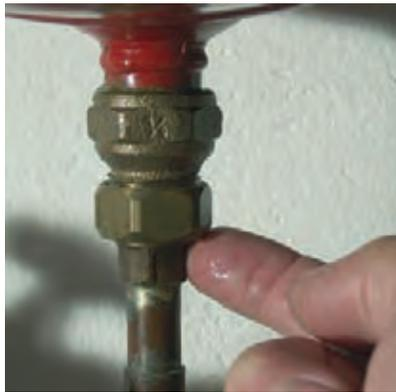
Nach der Montage des neuen Ausdehnungsgefäßes füllen Sie das Heizwasser wieder auf ca. 0,8 bar nach, kontrollieren die Verschraubung des Gefäßes auf Dichtigkeit und entlüften es.
