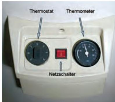
Sehen Sie sich erst dieses Bild an: es zeigt die Bedienelemente und die Temperaturanzeige an einem gängigen Warmwasserspeicher an. Der regelbare Thermostat ist für die Einstellung der Warmwasser-Temperatur im Speicher zuständig. Das Thermometer zeigt die Wassertemperatur an und mit dem Netzschalter kann bei Be-
