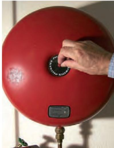
Schrauben Sie die Kunststoffkappe des Entlüftungsventils, das sich in der Mitte des Entlüftungsgefäßes befindet, wie einen Flaschenverschluss auf.
