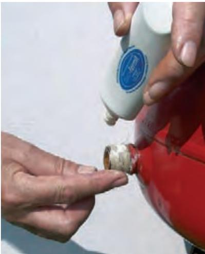
Das Gewinde des neuen Ausdehnungsgefäßes muss vor der Montage mit einer angemessen zuverlässigen Dichtung versehen werden. In den meisten Fällen wird z.B. eine Dichtung aus aufgewickeltem Hanf mit Dichtungspaste angewendet (sehen Sie sich vorher einfach an, wie das alte Gefäß abgedichtet wurde und halten Sie sich daran).
