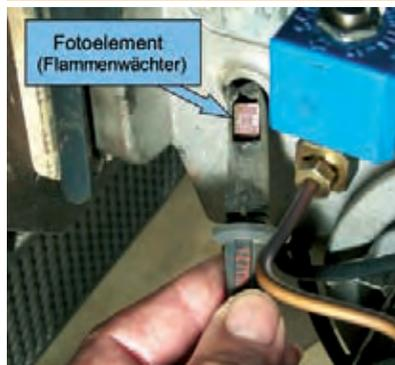
Ziehen Sie das Fotoelement aus dem Brenner so weit heraus, dass Sie es z.B. mit einem Taschentuch voll gegen das Licht im Raum abdecken und mit einer kleinen Ta-
