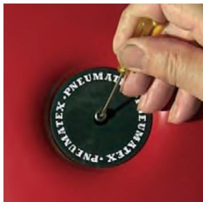
Drücken Sie den dünnen Stift in der Mitte des Entlüftungsventils mit einem dünnen Gegenstand kurz ein, um das Gefäß zu entlüften. Hat es geholfen, dann ist das Problem gelöst. Andernfalls muss das Ausdehnungsgefäß ausgewechselt werden.
