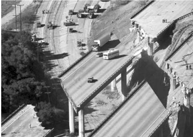
Bild 1.4: Brückeneinsturz bei einem Erdbeben in Northridge 1994 USA
