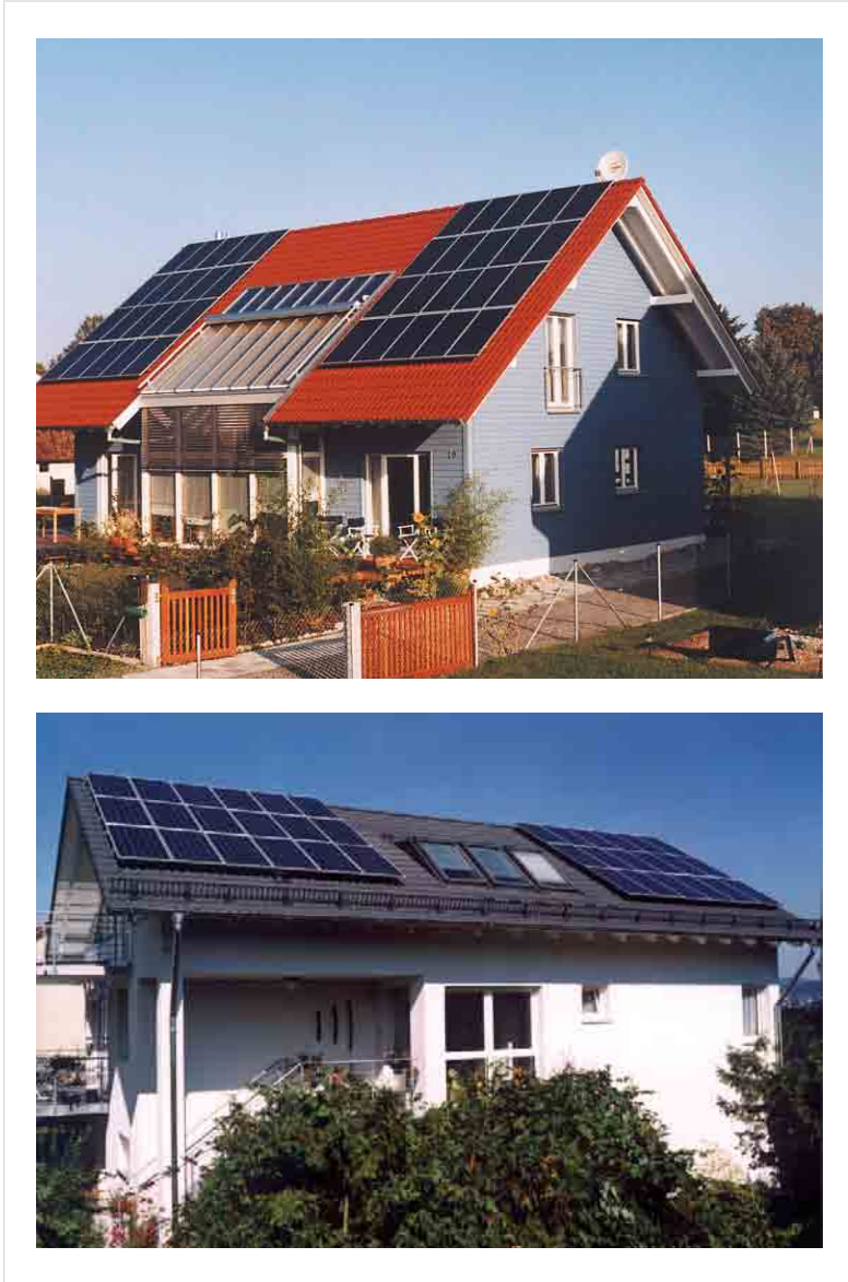
Abb. 4.1: Privathäuser mit Photovoltaik-Aufdachanlagen (Fotos: Solarworld)
