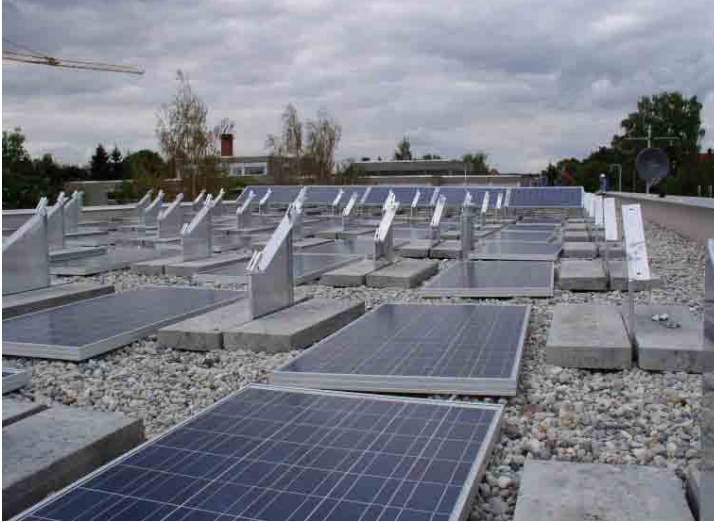
Abb. 4.14: Gehwegplatten halten die Modulständer an Ort und Stelle. (Foto: Schletter)
