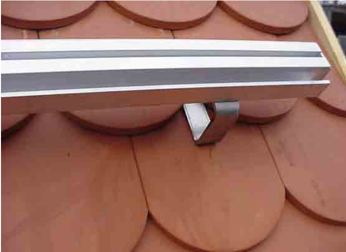
Abb. 4.4: Montierte Profil- oder Tragschiene auf einem Dach mit Biberschwanzziegeln. (Foto: Schletter)
