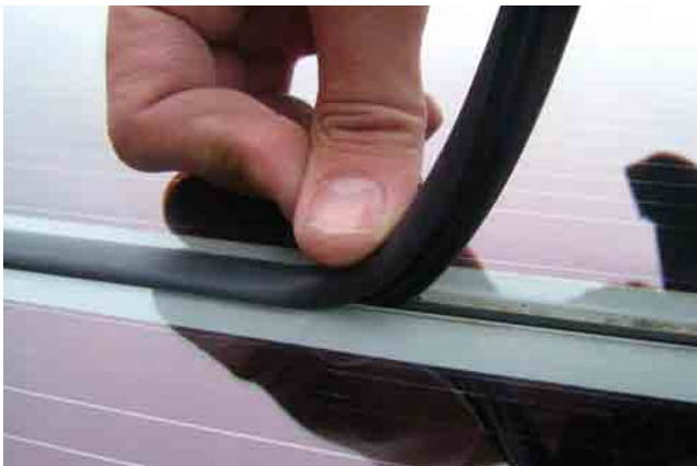
Abb. 4.21: Anbringen einer Dichtung zwischen zwei Laminaten. (Foto: Schletter)
