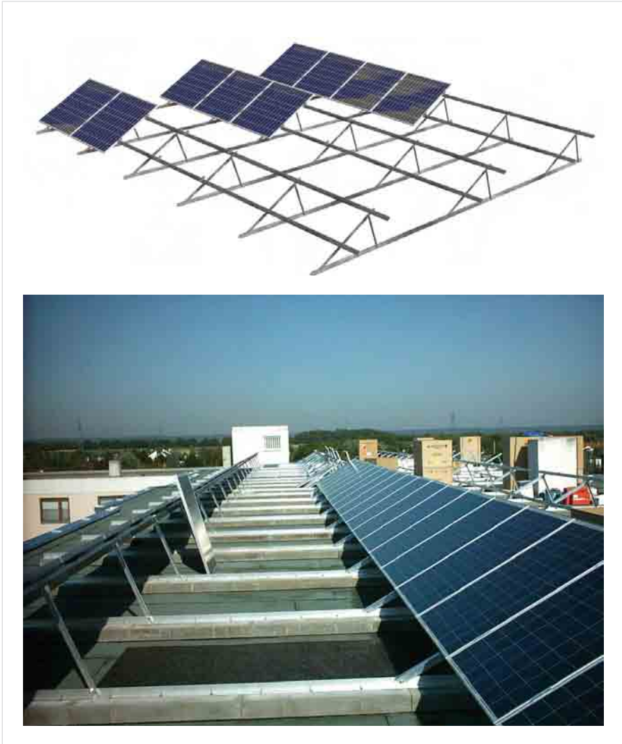
Abb. 4.13: Bei einer Flachdachanlage ist auf genügend Abstand zwischen den Modulreihen zu achten. (Fotos: Schletter)
