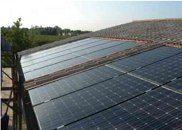
Abb. 4.22: Ist nur ein Teil des Dachs mit Solarmodulen belegt, muss auch der Übergang zu den Dachziegeln abgedichtet sein. (Foto: Schletter)
