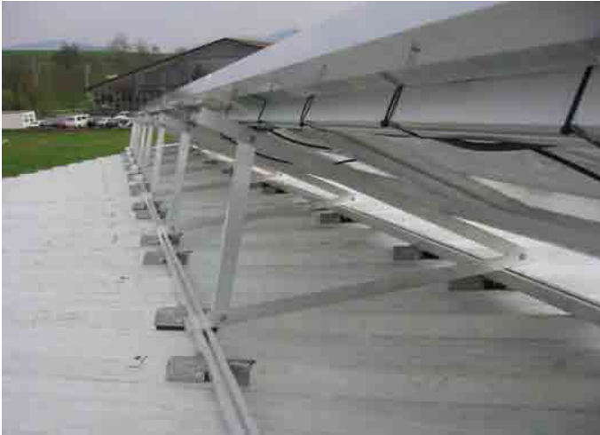
Abb. 4.7: Die an den Falzsteigen angeschraubten Klauen halten Metallschienen, die die Konstruktion mit den Solarmodulen tragen. (Foto: Schletter)
