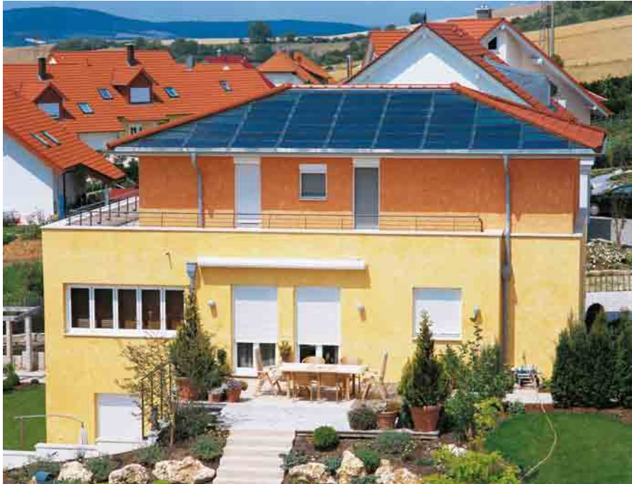
Abb. 4.19: Indachanlage auf einem Privathaus in Tauberbischofsheim. (Foto: SMA Technologie AG)
