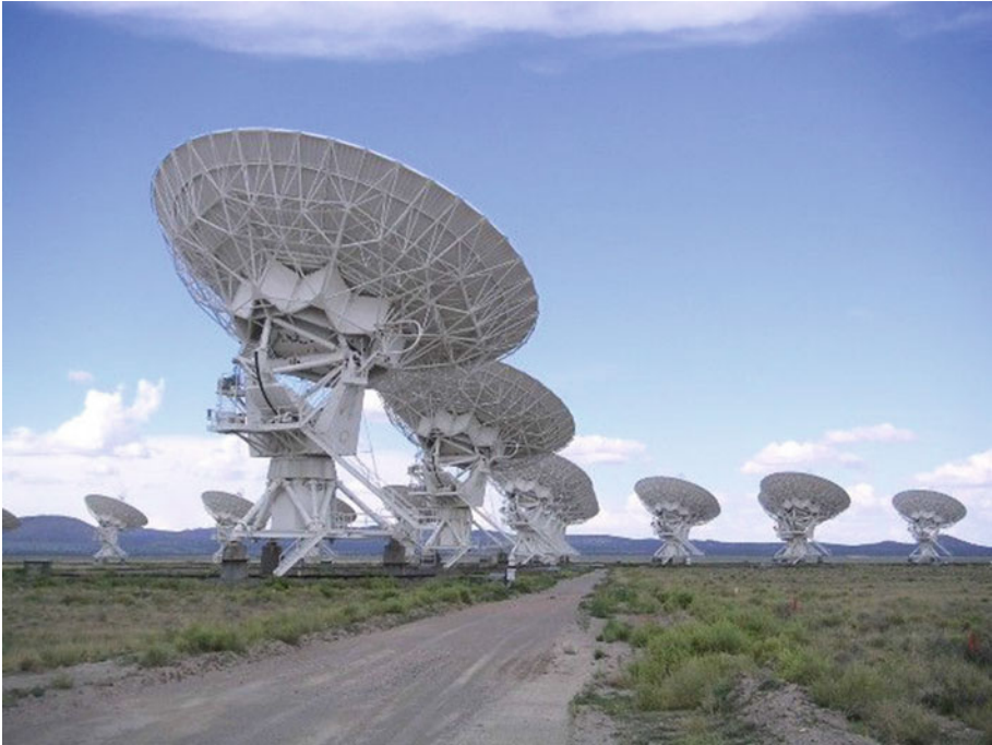
Abb. 1.2 Das Auflösungsvermögen eines Teleskops hängt von der Wellenlänge ab, bei der beobachtet wird. Deshalb müssen Radioteleskope wesentlich größer gebaut oder zusammenschaltet werden (Interferometrie), um bei den langen Radiowellen ein gutes Auflösungsvermögen zu erreichen
