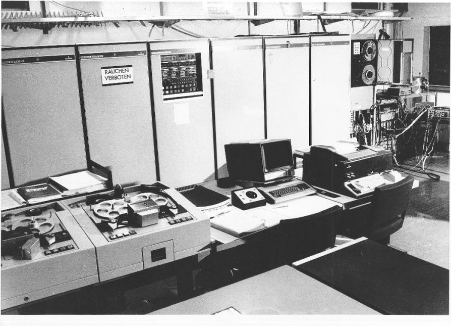
**Abb. 1.** Prozessrechner Siemens 306 um 1975, rechts Peripherie und Experiment; Arbeitsplatz mittig mit Rollkugel (umgekehrte Maus) und Vektorgraphikschirm
