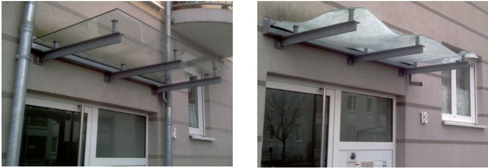
Abbildung 1.1 Resttragfähigkeit einer punktförmig gelagerten Horizontalverglasung aus Verbund-Sicherheitsglas
