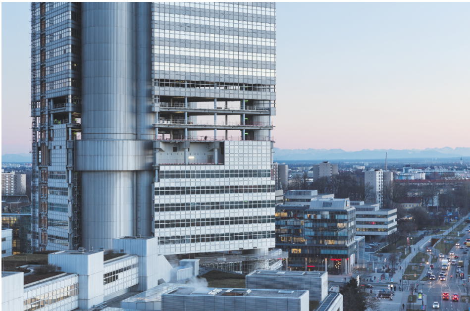
Bild 2-1 Schrittweise Sanierung der Fassade (Foto: ©HGEsch).
