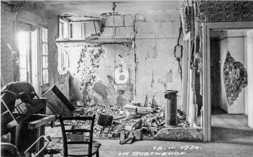
Durch Artilleriebeschuss zerstörte Wohnung im Goethehof in Kaisermühlen, Februar 1934.
