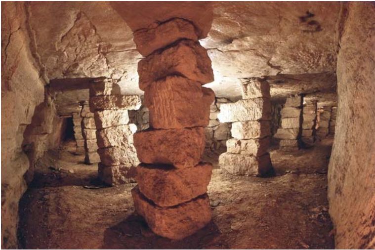
Pfeiler aus aufeinandergestapelten Steinen stützen diesen Steinbruch unter Paris.
