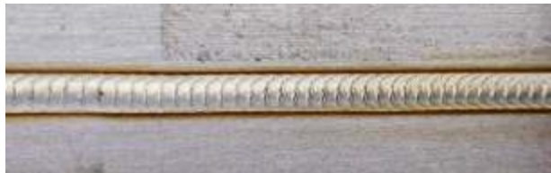
Cordón de soldadura ejecutado en acero al carbono
