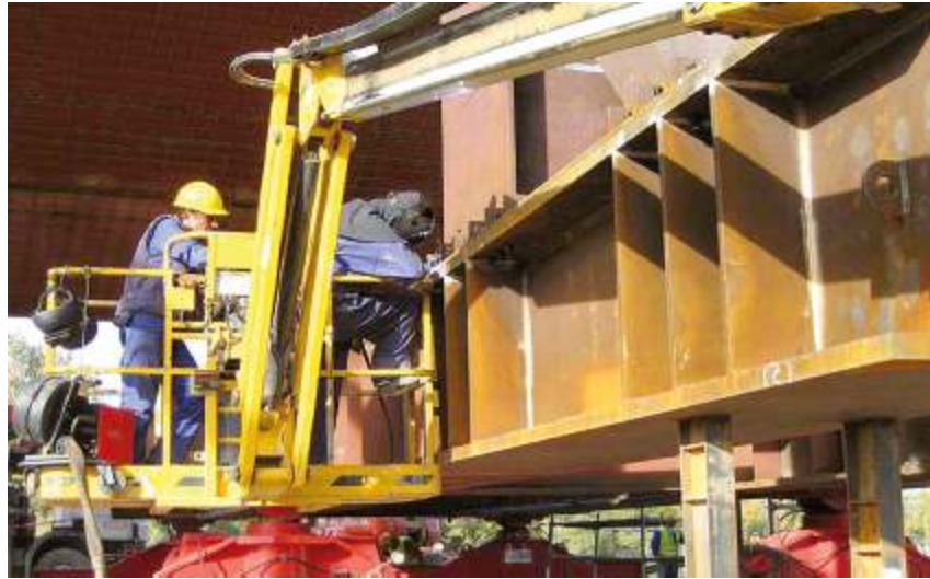
Trabajos de soldadura en un puente metálico en un taller metalúrgico
