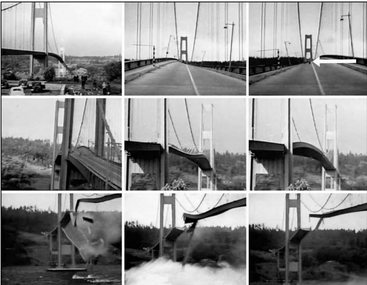
Abb. 4: Die Tacoma-Narrows-Brücke zerbricht im November 1940. Die Wellen breiteten sich ähnlich aus wie in einer trockenen Spaghetti.
