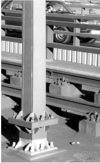
Bild 1.7 Fahrdradmast für Straßenbahn (Mastfuß)
