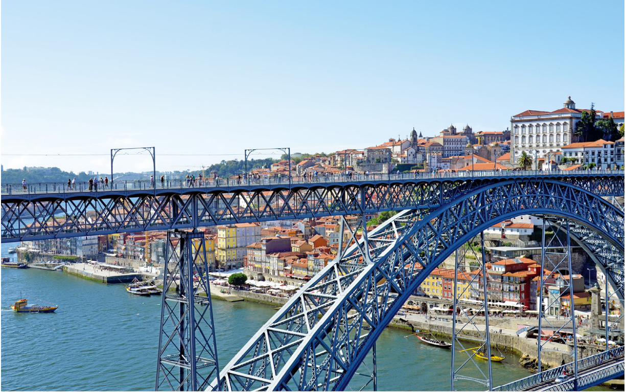
Die obere Ebene der Brücke Dom Luís I. ist zugleich die schönste Aussichtsplattform der Stadt (048po-ps)
