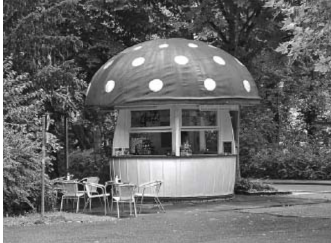
Abb. 2-4 Mittlerweile unter Denkmalschutz stehender Milchpilz in Regensburg, errichtet im Jahr 1954 von der Firma Waldner, die insgesamt 50 solcher kleiner Verkaufsstellen für Molkereiprodukte baute.
