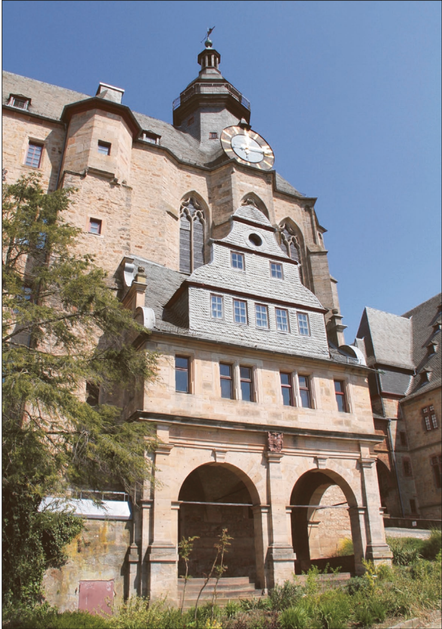
Abb.1 Aus dem Dach der Schlosskapelle ragt der »Hausmannsturm« heraus, auch Schlossturm, Uhrturm oder Dachreiter genannt. Foto: Mareike Gill.
