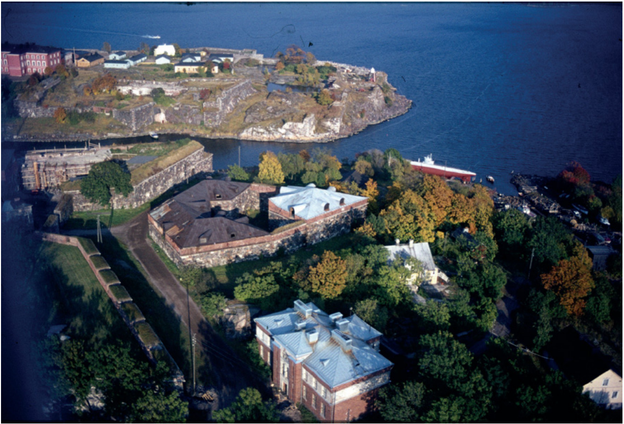
Ilmakuva itään: Hyvä omatunto -raveliinissa oli vielä 70-luvulla venäläiskauden aikainen peltikate. Vasemmalla on Kunnia-bastionin pitkä muuri, Tykistölahden rannassa vuonna 1973 museoitu Vesikkosukellusvene. Valokuva: Suomenlinnan hoitokunnan kuva-arkisto/A&M Oy, 1976
