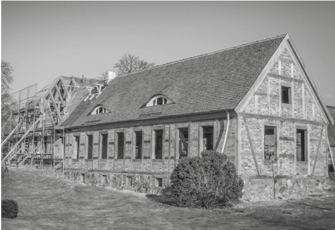
Das Krumbecker Küchen- und Wirtschaftshaus während der Restaurierung
