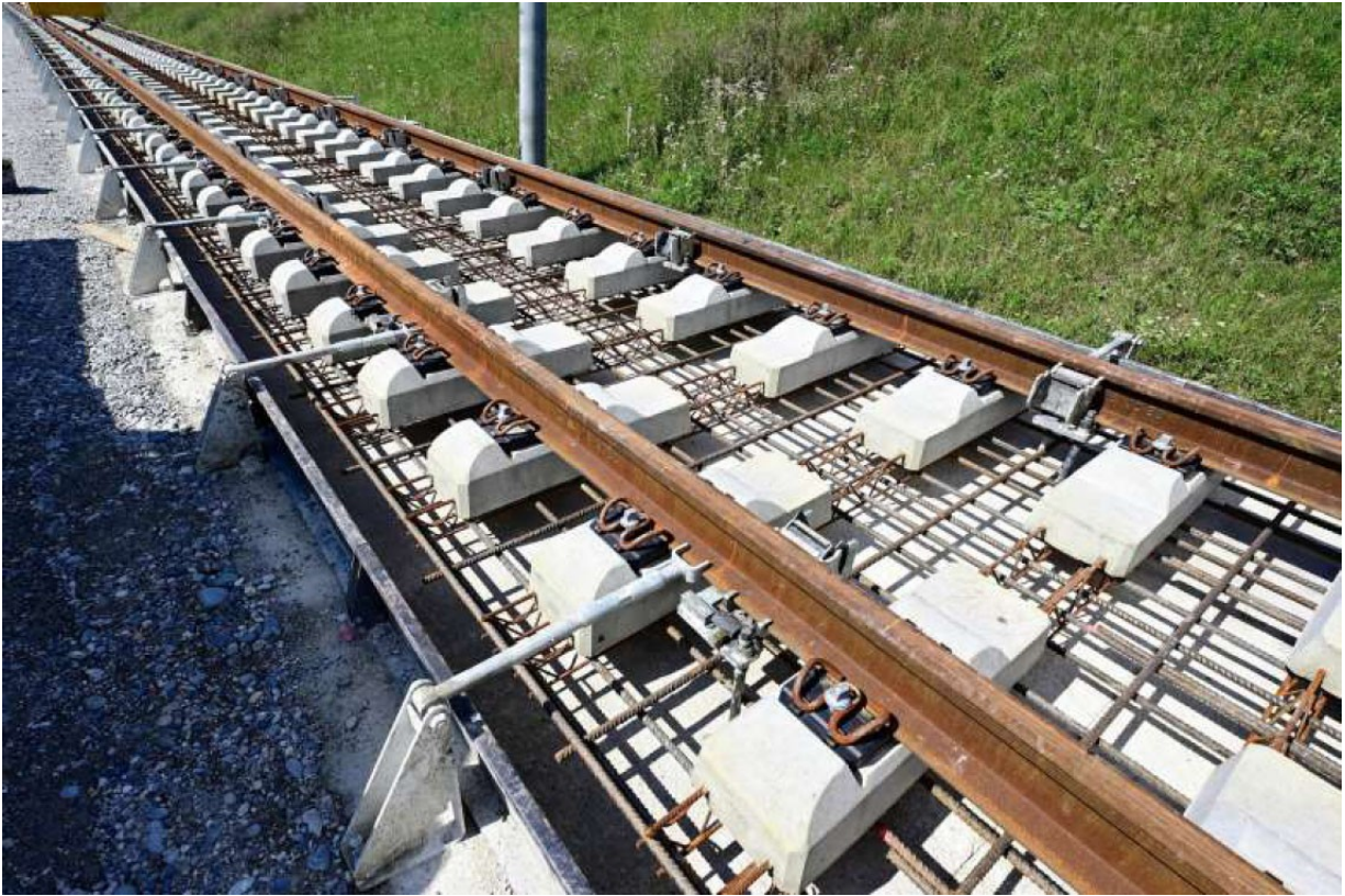
Abbildung 7: Der Bau der festen Fahrbahn 19 ist Präzisionsarbeit im Zehntelmillimeterbereich. Die Schwellenblöcke werden in den Gleistrog eingebaut und justiert, es folgt anschließend die Fixierung mittels Füllbeton. Das Bild zeigt die Neubaustrecke zwischen Stuttgart und Ulm. [Copyright mit freundlicher Genehmigung Arnim Kilgus]
