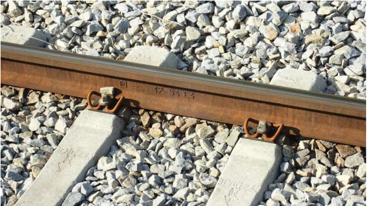
Abbildung 6: Neu verlegte Schiene auf neuen Betonschwellen im Schotterbett: Diese drei Bestandteile des Fahrweges tragen und verteilen die großen Gewichte der Eisenbahnfahrzeuge. Jede Schiene besitzt ein Walzzeichen, hier mit folgenden Informationen: Produktion: 2017, Material: Kohlenstoff-Mangan-Stahl, Gewicht: 54 kg pro Meter, Herkunft: Walzwerk Huta Katowice (Polen). Es handelt sich somit um das Standard-Schienenprofil der Bahn auf Hauptstrecken und im Bahnhofsbereich. [Copyright Frank Hole]
