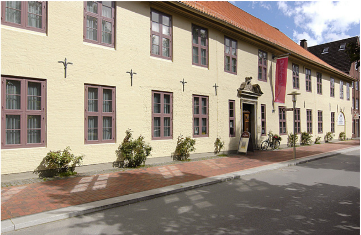
Das ehemalige Wohnhaus des Christian von Pentz und heutige Detlefsen-Museum Glückstadt (Foto: Detlefsen-Museum).
