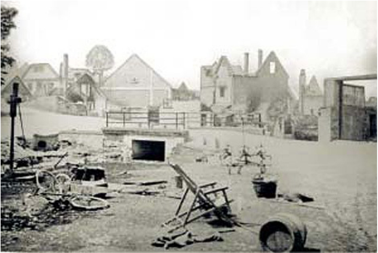
Nach der Plünderung und vor der Sprengung
