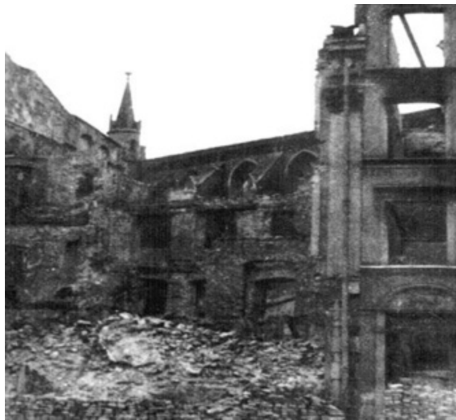
Zerstörung nach Bombenangriffen
