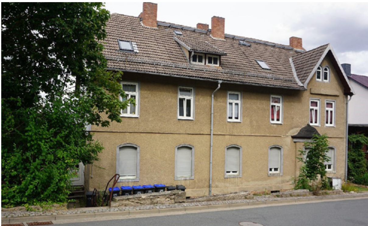
Töchterpensionat Haus „Daheim“, heute Wohnhaus, Steinbergstraße 22.
