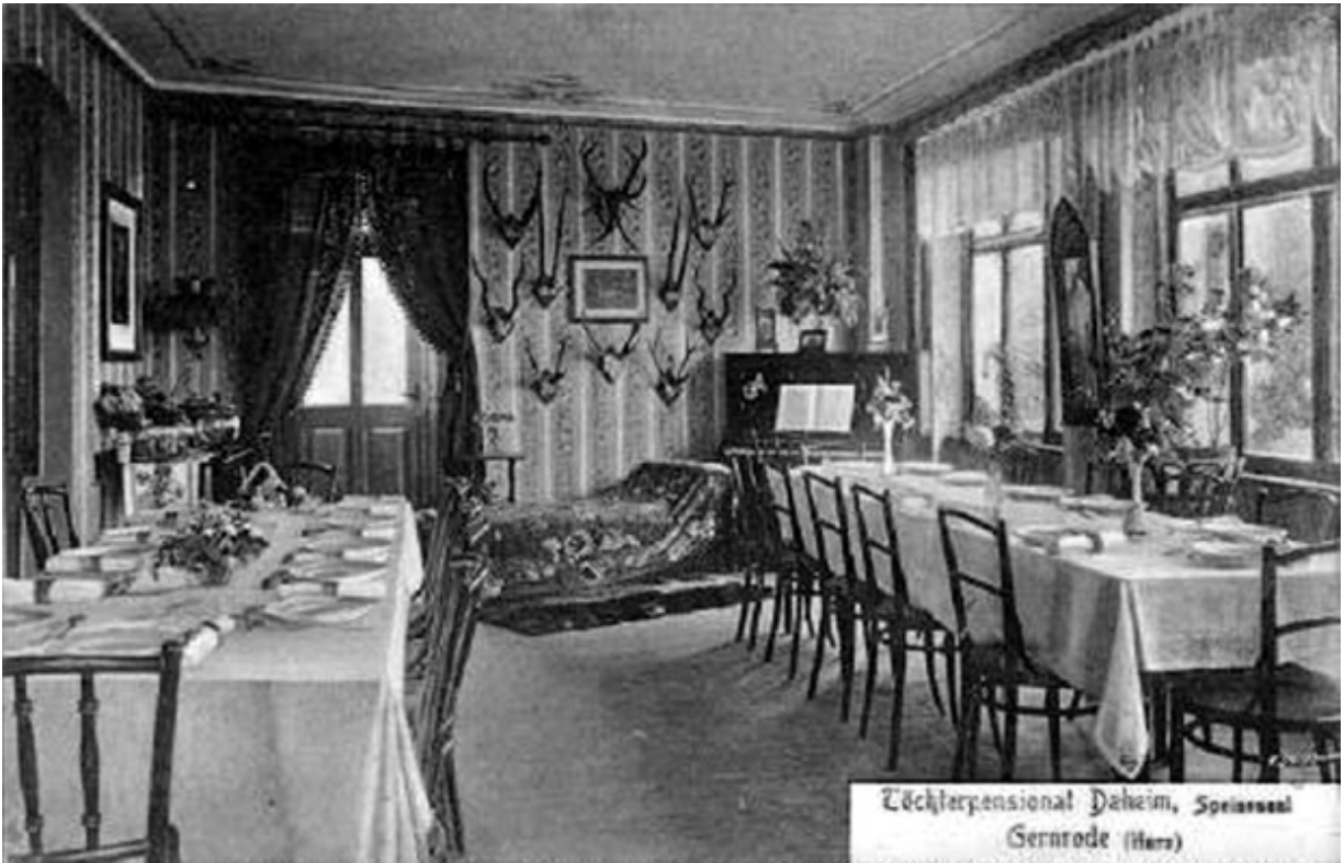
Töchterpensionat Haus „Daheim“, Speisesaal. Ansichtskarte vor 1910
