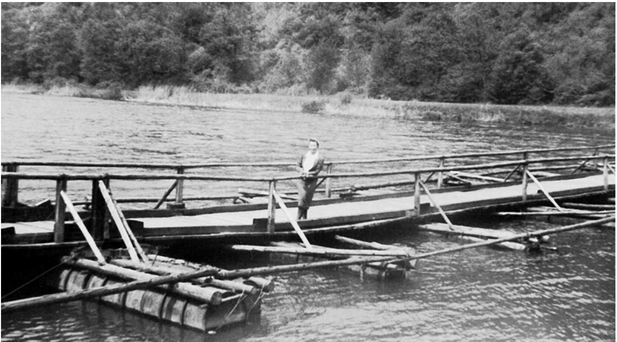
Abb. 17 Ponton-Brücke von Dreisbach zum Montclair-Ufer im Frühjahr 1940
