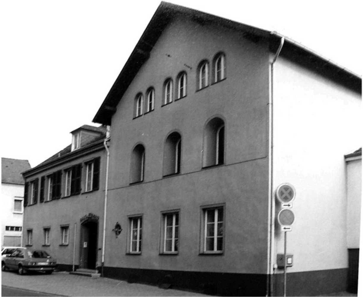
Ehemaliges Schwesternhaus der Beckinger Salvatorianerinnen in der Talstraße, das „Pius-Haus“, Zentrum der Schwesterntätigkeit im Ort
