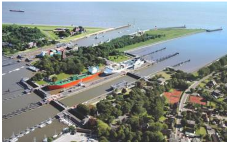
Die Schleusenanlage von Brunsbüttel Foto: Touristinfo Brunsbüttel
