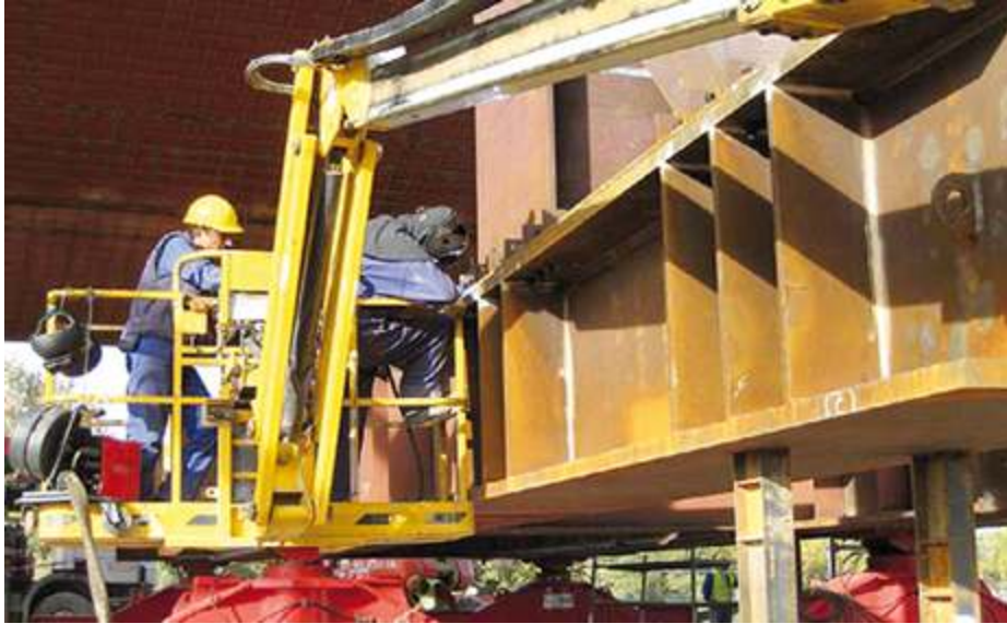
Trabajos de soldadura en un puente metálico en un taller metalúrgico
