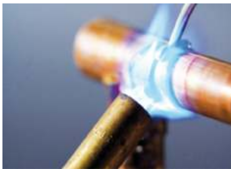
Soldadura de tuberías de cobre
