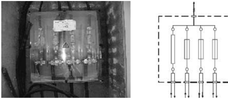
Figura 1.4. Fotografía y esquema de una CGP con acometida subterránea
