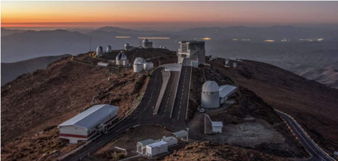
Die europäische Südsternwarte auf dem chilenischen Andengipfel La Silla. In der Bildmitte steht das kantige Gebäude des New Technology Telescope.
