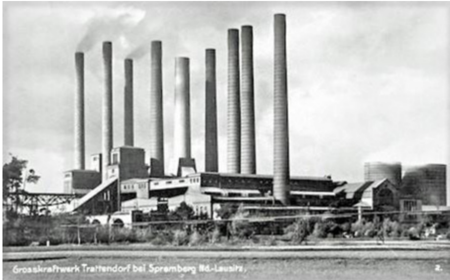
Das Kraftwerk Trattendorf Baubeginn 1915
