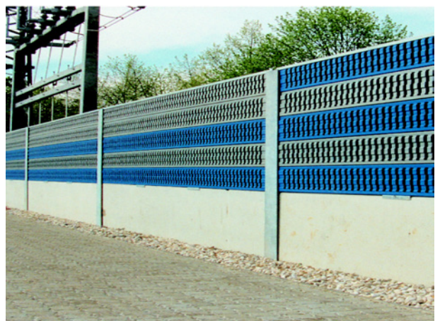
Bild 1.8 Ausrangierte thermoplastische Produkte können recycelt werden. Diese Schallschutzzitter von Polyplank AB sind dafür ein hervorragendes Beispiel. [Foto: Polyplank AB]
