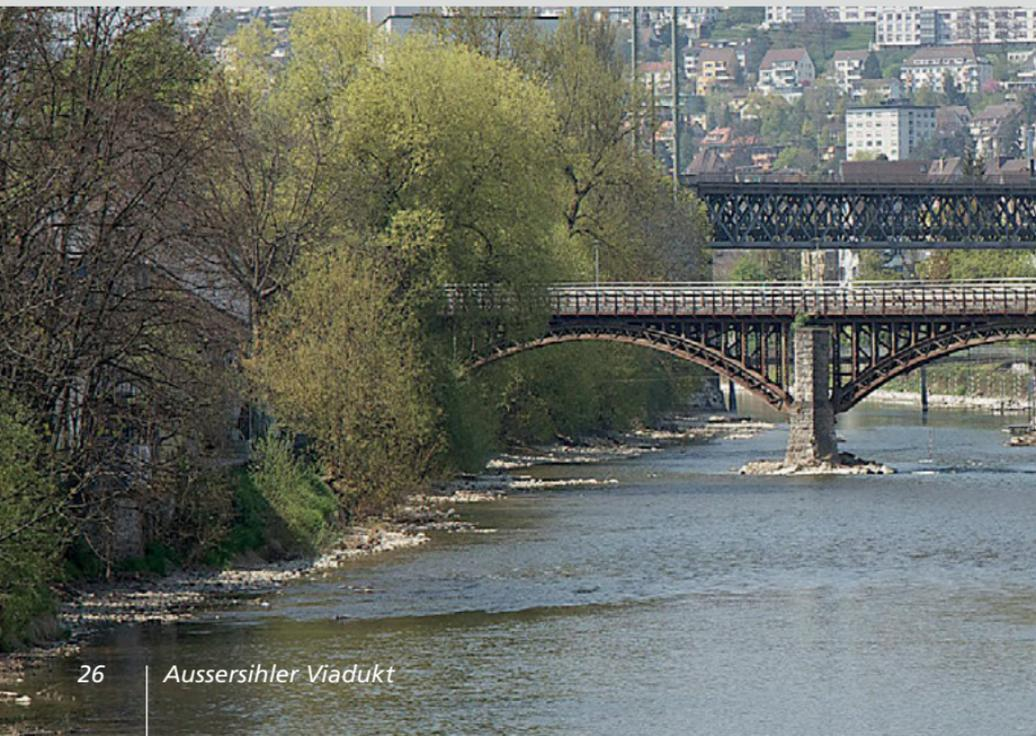
konnte – ohne störendes Lehrgerüst im Gleisfeld – die Betonplatte erstellt werden. Die logistischen Anforderungen waren enorm, die Bauzeit von 2000 bis 2004 entsprechend lang. Damit nicht in ein paar Jahrzehnten der Korrosionsschutz unter Betrieb erneuert werden muss, wurde wetterfester Stahl verwendet, der eine Schicht aus Edlorost bildet und so die weitere Korrosion unterbindet.
