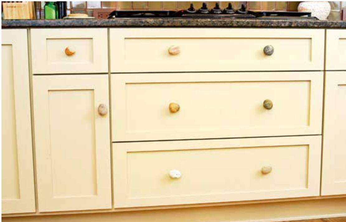
**Aufschlag!** Bei einer Schublade mit aufschlagendem Vorderstück verdeckt dieses die dahinter liegende Front des Möbels größtenteils. Zwischen den Vorderstücken liegen umlaufende, gleichmäßige Fugen von etwa 3 mm.
