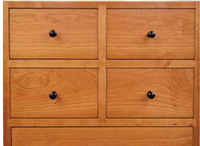
**Enge Toleranzen.** Einschlagende Schubladen müssen sorgfältig eingepasst werden, um gleichmäßige Fugen zu erzielen. Das Ergebnis sieht jedoch sehr sauber aus und spricht von hohen handwerklichen Fähigkeiten.
