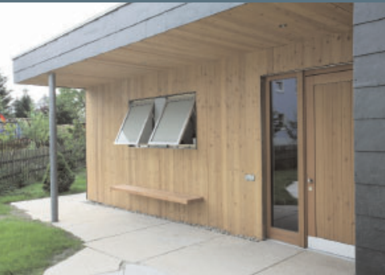
Niveaugleiche Haus- und Terrasseneingänge lassen sich ideal durch ein auskragendes Dach schützen. Nebenbei können so qualitätvolle überdachte Freibereiche entstehen (Seeger-Ullmann Architekten, s. S. 38; Foto: Rathscheck Schiefer)
