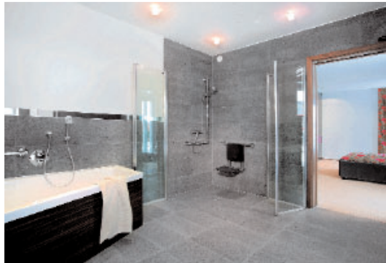
Ein komplett rollstuhlgerechtes Bad: Haltegriffe um das WC, ein unterfahrbares Waschbecken sowie eine bodengleiche, ausreichend große Dusche mit Klappsitz (Fotos: SchwörerHaus, s. S. 12).
