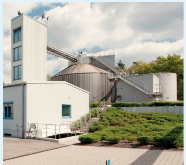
Seite 13: Durch den zusätzlichen Einsatz einer Hochlastfaulung in die bestehende Faulung, wird in Wagbach der Energiebedarf vollständig abgedeckt
