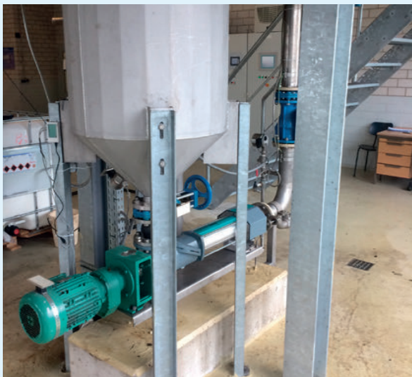
Seite 10: Pumpen mit „Full Service in Place Konzept“ sind kompakt, halten länger, vereinfachen Eingriffe in die Pumpentechnik und sparen Zeit bei Inspektionen, Wartung, Reparatur und Reinigung
