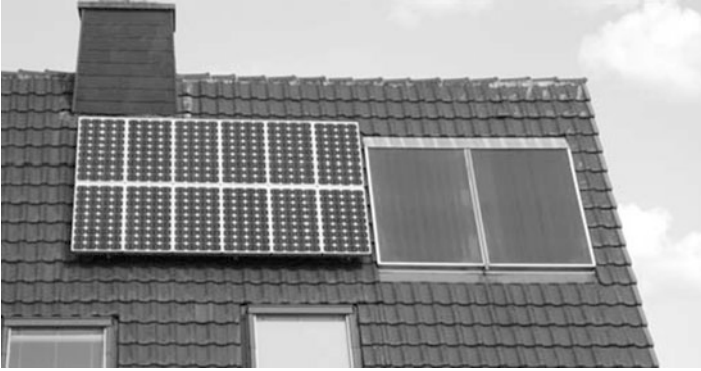
Abb. 1.1 Photovoltaikmodule (links) und Solarthermiekollektoren (rechts) nutzen beide die Solarenergie
