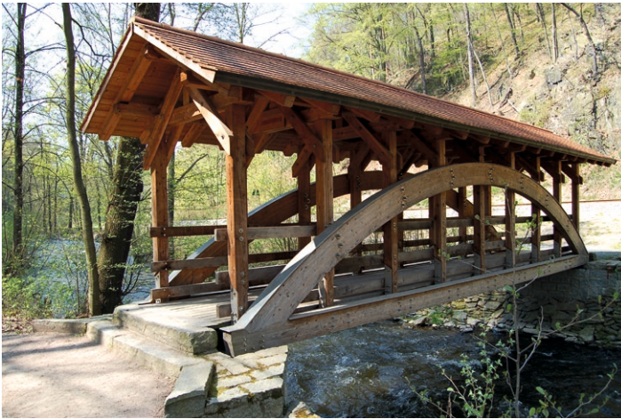
Bild 1.3 Baulicher Holzschutz bei einer Brücke
