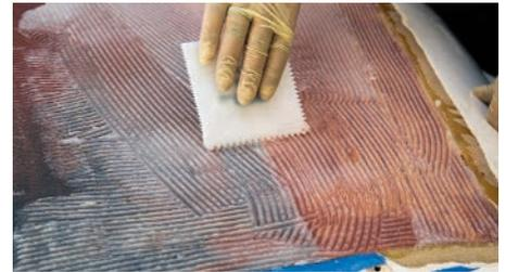
**6** Dafür wird das Harz wie zuvor mit Baumwollflocken ange-dickt und mit einem feinen Zahnpachtel aufgetragen
