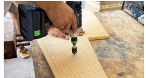
**6** Da der Aufbau auch in Längsrichtung gewölbt ist, folgen um 90 Grad versetzte Schnitte. Zudem bohrt man vier Millimeter große Löcher in den Schaum. Sie füllen sich ...
