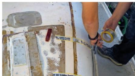
**8** Wie beim Einkleben des Kernmaterials werden die Kanten mit Klebeband fixiert, der Rest wird mit Gewichten ...
