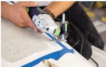
**4** Mit einer Oszillationssäge wird dann das etwa vier Millimeter starke Außenlaminat rundherum bis zum Kern durchtrennt
