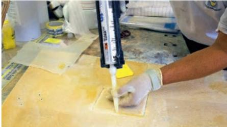
**4** Den Ausschnitt von unten einlegen und die Fuge mit angedicktem Harz füllen. Hier wurde SIX10 aus der Kartusche verwendet. Normales Harz mit Baumwollflocken tut es auch
