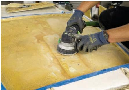
**4** Schaum- und Spachtelreste werden mit 36er-Papier abgeschliffen. Dank der groben Körnung entsteht eine sehr raue Oberfläche, auf der sich das Epoxidharz beim Einkleben des neuen Kerns optimal verkrallen kann
