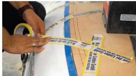
**11** Die Ränder der Platten lassen sich gut mit Klebeband fixieren. Zum flächigen Anpressen eignen sich Sandsäcke sehr gut. Werden wie in diesem Fall Autoakkus verwendet, ...
