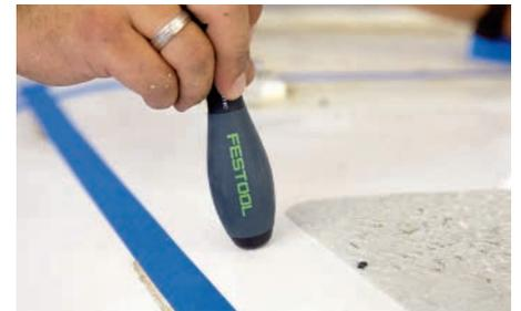
**3** An Stellen, an denen es dumpf klingt, ist der Kern abgerissen. Um den beschädigten Bereich herum wird mit etwas Zugabe abgeklebt
