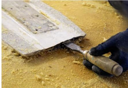
**2** Am Mastfuß ist das Außenlaminat beim Abnehmen gebrochen. Augenscheinlich wurde hier in der Vergangenheit bereits repariert, allerdings nicht gut. Die Sperrholzunterlage ist nass und muss ebenfalls entfernt werden
