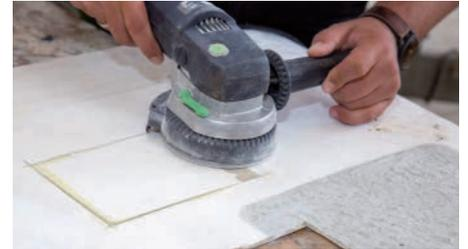
**6** Die endgültige Festigkeit erhält die Reparatur durch das von oben aufgebraachte Laminat. Dazu wird der Bereich etwa 0,6 Millimeter tief ausgeschliffen. Das entspricht ...
