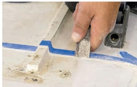
**5** Anschließend kann der Deckel mithilfe eines Stecheisens abgehoben werden. In der Regel trennt er sich problemlos vom Kern
