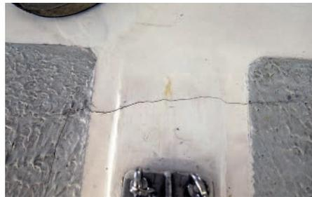
**2** Am Übergang zum Mastfuß ist das Deck bereits gebrochen. Um den Schaden einzugrenzen, wird der gesamte Aufbau abgeklopft
