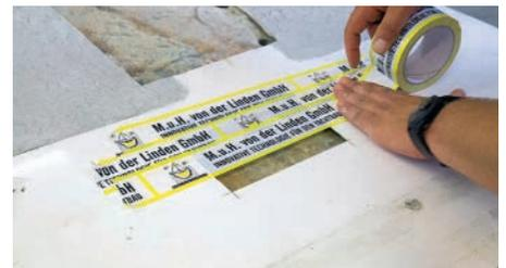
**3** Damit das Harz beim Einkleben des Ausschnitts nicht weglaufen kann, das Loch von oben verschließen. Dafür reicht einfaches Klebeband oder eine Kunststofffolie
