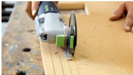
**5** ... von unten geschlitzt. Der Tiefenanschlag der Oszillationsäge wird auf drei Viertel der Materialstärke gestellt. Die Schnitte folgen der Außenkontur der Platte
