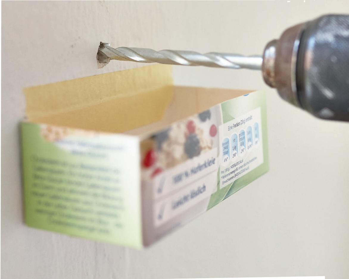
**Ist gerade kein Staubsauger da oder niemand, der dir das Staubsaugerrohr hält, kannst du auch eine kleine Pappschachtel mit Malerkrepp unter die Bohrstelle kleben. So fällt der Bohrstaub einfach in die Schachtel.**
